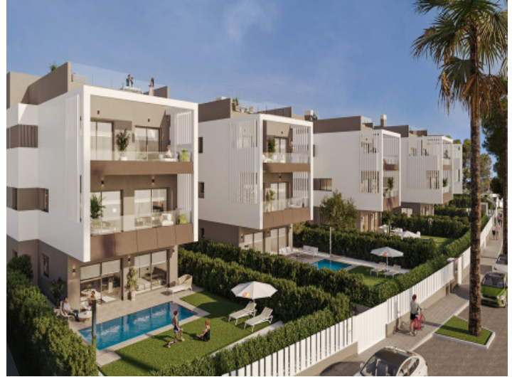
Ansicht auf die Anlage
