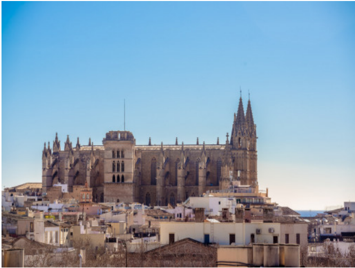
Blick auf die Kathedrale von der Gemeinschaftsdachterrasse
