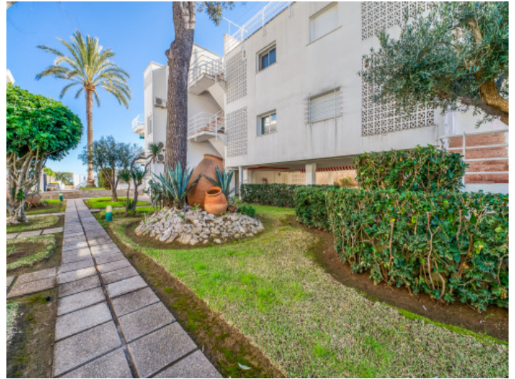
Aussenansicht des Gebäudes
