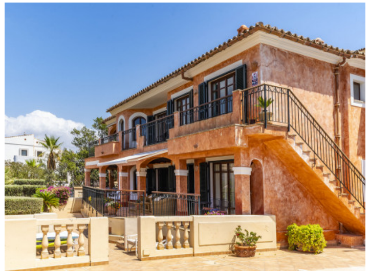
Außenansicht des Penthauses
