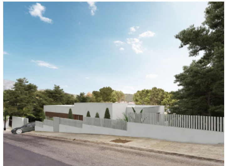
Blick von der Straße
