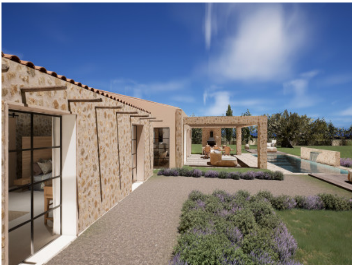
Ansicht auf die hintere Fassade und Garten
