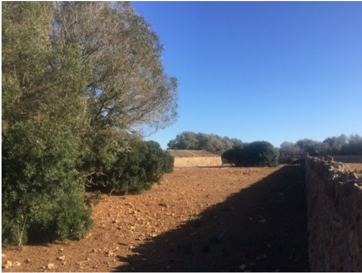
Mauer aus Naturstein
