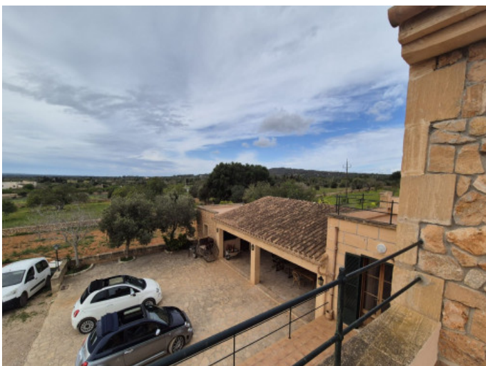
Terrasse mit Blick zur Garage
