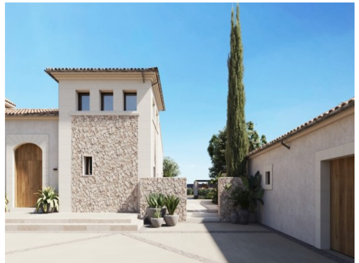
Außenbereich und Garage
