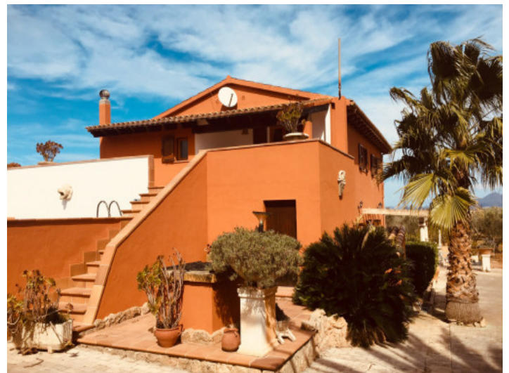
Südansicht des Hauses
