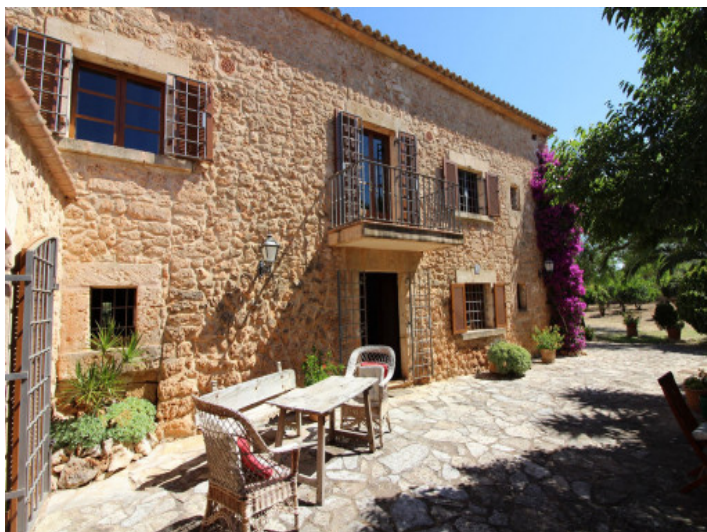
Frontansicht und Terrasse
